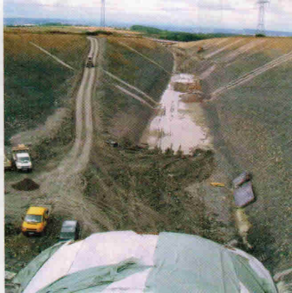
ICE Strecke Nürnberg-Erfurt, Tunnel Augustus- burg, Rohbodenbegrünung vorher
