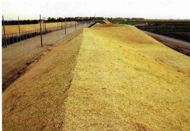
Lärmschutzwall entlang HL-Strecke Wien-Linz: Ansaat und Aufbringen einer Mulchschicht
