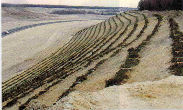
Erosionsschutz einer Kippe mit Totholzfaschinen und Magerrasen, vorher
