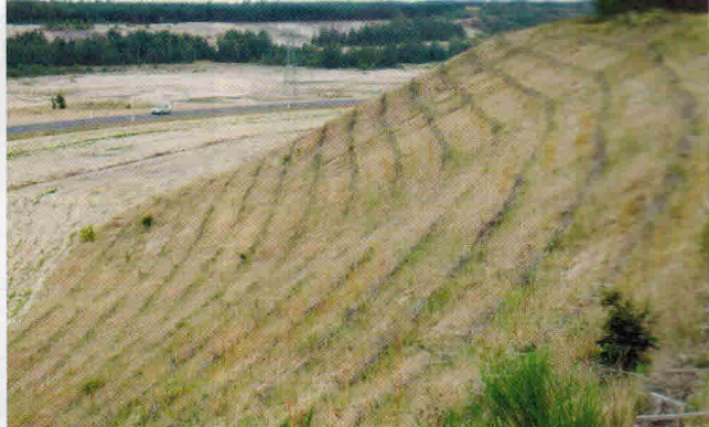
Erosionsschutz einer Kippe mit Totholzfaschinen und Magerrasen, nachher
